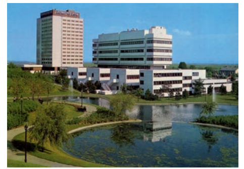
Z266 Wien Kurzentrum Oberlaa
